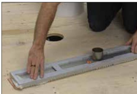
**2** Appliquez Schluter SET<sup>®</sup>, ALL-SET<sup>®</sup>, FAST-SET<sup>®</sup>, ou du ciment-colle non modifié sur le dessus du support à l'aide d'une truelle dentelée, puis enfoncez-le solidement sous le corps de caniveau. Fixez le raccord mécanique à la sortie et à la section de tuyau selon les instructions de fabricant.
