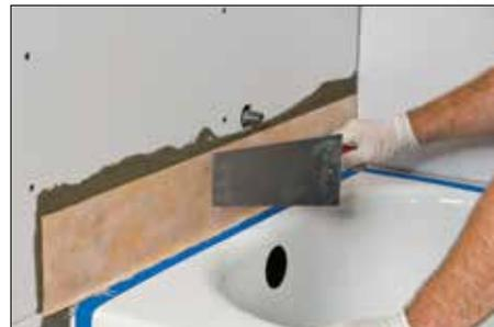
**3** Appliquez la bande d'étanchéité KERDI-BAND ou utilisez des sections de la membrane KERDI coupées d'une largeur de 5" (125 mm). Enfoncez solidement la membrane dans le ciment-colle et KERDI-FIX pour assurer une adhésion adéquate et retirer les poches d'air.
