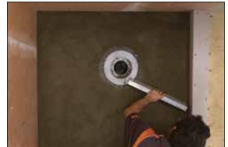
**2** La chape est étalée à égalité du dessus de la bride de collage du drain KERDI-DRAIN. Faites une pente dans le lit de mortier à 1/4" (6 mm) par 12" (305 mm) en utilisant le guide de nivellement au périmètre et la bride de collage.
