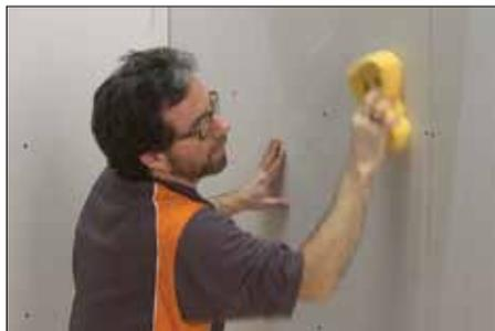
**1** Retirez la poussière ou d'autres débris de la surface du support solide. Humidifiez les substrats particulièrement secs et poreux dans le but de prévenir l'assèchement prématuré du ciment-colle ou la formation d'une peau.
