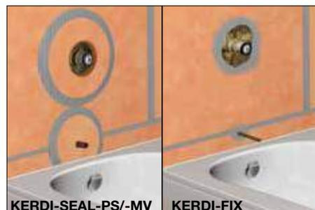
**6** L'étanchéité de tout passage de tuyaux dans la membrane (valves, pomme de douche, etc.) doit être assurée au moyen des matériaux KERDI-SEAL-PS/-MV, KERDI-FIX ou d'un autre scellant adéquat.
