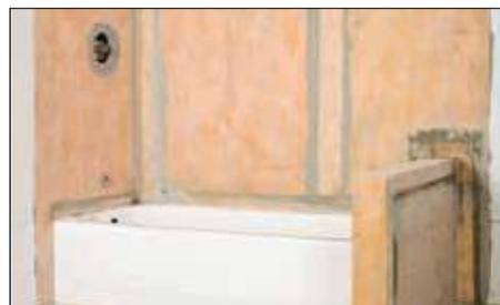
**8** Une fois la membrane posée, ainsi que les jonctions, les coins et les murs bas réalisés et donc imperméabilisés, l'assemblage est prêt à carrelage. Pour obtenir les instructions d'installation du carrelage, veuillez consulter la page 30.
