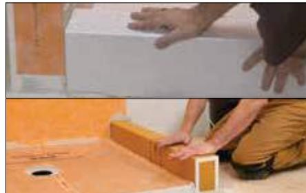
**2** Pressez le seuil fermement en place. Regardez en-dessous du seuil ou de la rampe pour vous assurer d'avoir un recouvrement complet.
