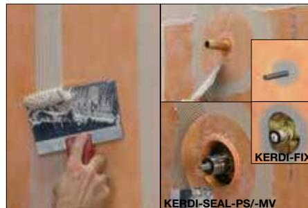
**3** On réalise les joints en superposant sur 2" (50 mm) les feuilles de membrane ou en disposant les feuilles côte à côte et en centrant sur les raccords des bandes d'étanchéité KERDI-BAND. L'étanchéité de tout passage de tuyaux dans la membrane (valves, pomme de douche) doit être assurée au moyen des matériaux KERDI-SEAL-PS/-MV, KERDI-FIX ou d'un autre scellant adéquat.
