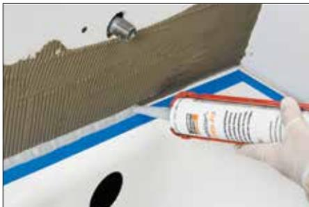
**2** Disposez du ruban à masquer pour protéger la baignoire. Appliquez Schluter SET<sup>®</sup>, ALL-SET<sup>®</sup>, FAST-SET<sup>®</sup> ou du ciment-colle non modifié sur le support solide à l'aide d'une truelle à dents en V de 1/4" x 3/16" (6 mm x 5 mm) ou de la truelle KERDI-TROWEL. Remplissez complètement l'espace de 1/4" (6 mm) entre le support solide et la baignoire d'adhésif KERDI-FIX ou d'un autre scellant approprié.
