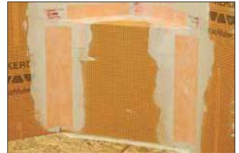
**3** Posez les bandes KERDI-BAND et les coins KERDI-KERECK ou KERDI-KERS-B (pour le banc triangulaire) afin de recouvrir tous les raccords et coins, en assurant un chevauchement minimum de 2" (50 mm), puis collez la membrane dans le ciment-colle en vous assurant de réaliser une couverture complète et d'enlever les poches d'air.
