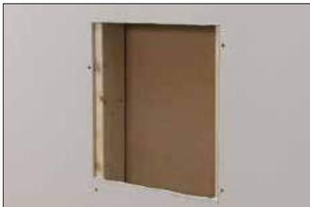
**1** Déterminez l'emplacement désiré de la niche et faites le tracé du contour extérieur de la bride KERDI-BOARD-SN, en vous assurant que les lignes sont de niveau et bien droites. Pratiquez l'ouverture dans le panneau de gypse de sorte que la niche soit supportée des deux côtés par les montants ou d'autres éléments de charpente murale.
