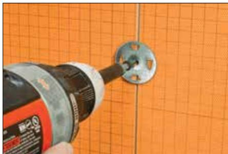
**2** Placez les panneaux sur le centre des montants. Les vis peuvent être fixées entre les panneaux adjacents, de façon à ce que les rondelles chevauchent deux panneaux. Laissez un espace maximal de 12" (30 cm) entre le centre de chaque ancrage sur les murs et de 6" (15 cm) sur les plafonds.
