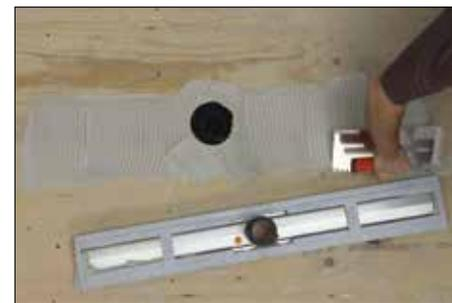
**3** Appliquez Schluter SET<sup>®</sup>, ALL-SET<sup>®</sup>, FAST-SET<sup>®</sup>, ou du ciment-colle non modifié sur le substrat à l'aide d'une truelle dentelée à l'endroit destiné à recevoir le drain. Préparez la section de tuyau et le siphon au moyen de nettoyant, d'apprêt et de colle pour ABS ou PVC conformément aux instructions du fabricant de l'adhésif.
