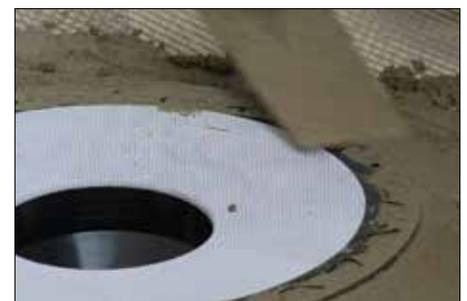
**2** Bourrez le mortier sous la bride de collage jusqu'à l'orifice, de façon à assurer le support adéquat et uniforme du drain, puis nivelez la surface. Formez ensuite le lit de mortier selon les instructions qui précèdent.
