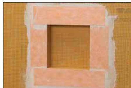
**3** Scellez les jonctions entre la niche et les murs à l'aide des bandes KERDI-BAND et Schluter SET®, ALL-SET®, FAST-SET®, ou du ciment-colle non modifié, en assurant un chevauchement de 2" (50 mm) dans toutes les directions.
