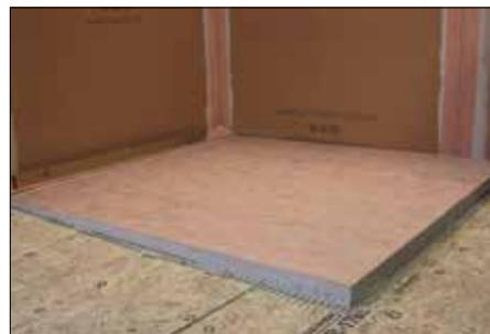
**1** Tout travail de nivelage de plancher doit être fait avant la pose de la base de douche. Si nécessaire, coupez à la dimension voulue la base de douche avant l'installation. La douche peut également s'étendre au-delà de la base, auquel cas on recouvrira le sol d'un lit de mortier et on y appliquera la membrane KERDI.
