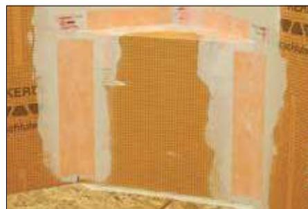
**1** Appliquez une couche de Schluter SET<sup>®</sup>, ALL-SET<sup>®</sup>, FAST-SET<sup>®</sup>, ou ciment-colle non modifié au plancher et sur le mur à l'aide d'une truelle à dents carrées ou en U de 1/4" par 3/8" (6 mm x 10 mm).
