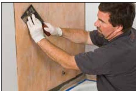
**4** Appliquez Schluter SET<sup>®</sup>, ALL-SET<sup>®</sup>, FAST-SET<sup>®</sup>, ou du ciment-colle non modifié sur le support solide et les bandes KERDI-BAND posées au préalable. Encastrez la membrane KERDI dans le ciment-colle sur toute la surface pour assurer une adhésion adéquate et retirer les poches d'air.
