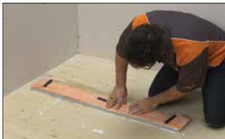
**4** Enfoncez solidement le support de caniveau et KERDI-LINE dans le mortier étendu sur le plancher et raccordez la section de tuyau au siphon. Assurez-vous que le drain KERDI-LINE est de niveau.
