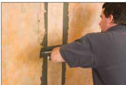
**5** On réalise les joints en superposant sur 2" (50 mm) les feuilles de membrane ou en disposant les feuilles côte à côte et en centrant sur les raccords des bandes d'étanchéité KERDI-BAND.
