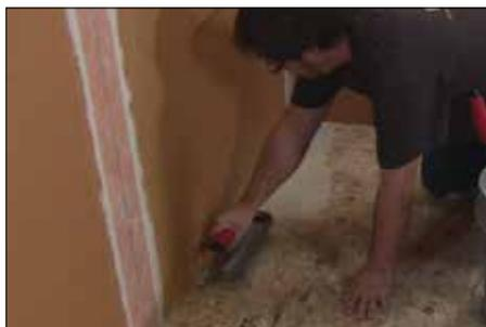
**1** Appliquez Schluter SET<sup>®</sup>, ALL-SET<sup>®</sup>, FAST-SET<sup>®</sup>, ou du ciment-colle non modifié sur le substrat à l'aide d'une truelle dentelée à l'endroit destiné à recevoir le drain et encastrez-y le support de caniveau.
