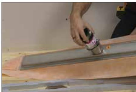
**1** Commencez l'installation en effectuant la pose à sec des composantes. Mesurez et coupez une section de tuyau qui servira à rattacher le raccord au siphon sous le plancher, en utilisant le support de caniveau comme espaceur.
