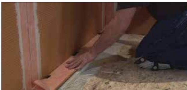
**2** Appliquez Schluter SET<sup>®</sup>, ALL-SET<sup>®</sup>, FAST-SET<sup>®</sup>, ou du ciment-colle non modifié sur le dessus du support, puis enfoncez solidement le corps de caniveau, de façon à ce que la bride de collage repose entièrement dans le ciment-colle. Assurez-vous que le drain KERDI-LINE est de niveau.
