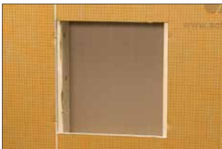
**1** Déterminez l'emplacement désiré de la niche et faites le tracé du contour extérieur de la bride KERDI-BOARD-SN, en vous assurant que les lignes sont de niveau et bien droites. Pratiquez l'ouverture dans le panneau KERDI-BOARD de sorte que la niche soit supportée des deux côtés par les montants ou d'autres éléments de charpente murale.
