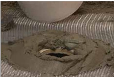
**1** Placez une couronne de mortier autour de l'orifice dans le plancher et pressez fermement le drain dans le mortier, puis nivelez la surface. La bride de collage doit être entièrement supportée pour prévenir les dommages à l'assemblage des carreaux (ex.: le coulis peut craquer autour du drain). Lorsqu'on pose le drain KERDI-DRAIN sur un substrat de bois, l'épaisseur minimale du mortier au périmètre de la bride de collage devra être de 1" (25 mm).
