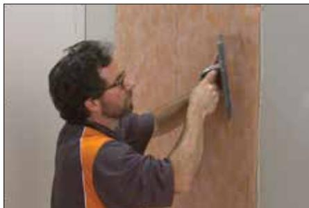
**2** Appliquez Schluter SET<sup>®</sup>, ALL-SET<sup>®</sup>, FAST-SET<sup>®</sup>, ou du ciment-colle non modifié sur le substrat à l'aide d'une truelle à dents en V de 1/4" par 3/16" (6 mm x 5 mm) ou de la truelle KERDI-TROWEL. Encastrez la membrane KERDI ou KERDI-DS dans le ciment-colle sur toute la surface pour assurer une adhésion adéquate et retirer les poches d'air.
