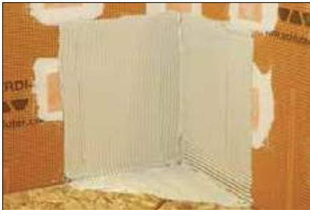
**1** Appliquez une couche de Schluter SET<sup>®</sup>, ALL-SET<sup>®</sup>, FAST-SET<sup>®</sup>, ou du ciment-colle non modifié au plancher et sur le mur à l'aide d'une truelle à dents carrées ou en U de 1/4" par 3/8" (6 mm x 10 mm).
