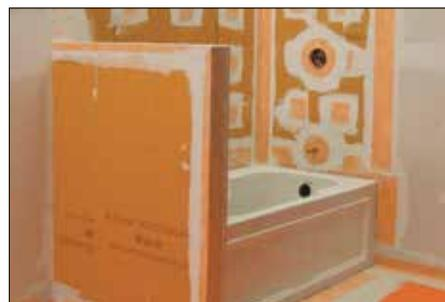
**7** Scellez les raccords aux murs bas en utilisant les coins préformés KERDI-KERECK-F et Schluter SET<sup>®</sup>, ALL-SET<sup>®</sup>, FAST-SET<sup>®</sup>, ou du ciment-colle non modifié.
