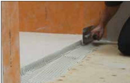
**1** Appliquez une couche de Schluter SET<sup>®</sup>, ALL-SET<sup>®</sup>, FAST-SET<sup>®</sup>, ou du ciment-colle non modifié au plancher et sur le bord de la base de douche à l'aide d'une truelle à dents carrées ou en U de 1/4" par 3/8" (6 mm x 10 mm).
